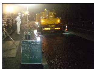
【スーパータックゾールS散布状況】
