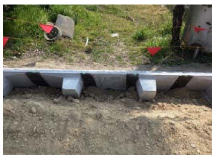
写真(6)：吸出防止材設置完了
