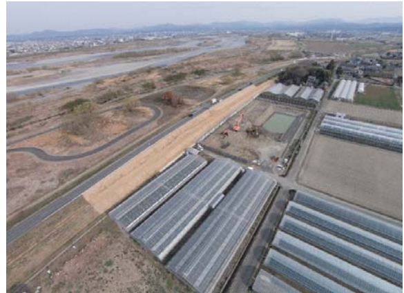
写真：完 成(航空写真)
