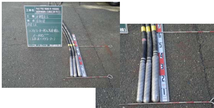
高周波バイブレーターのマーキング
