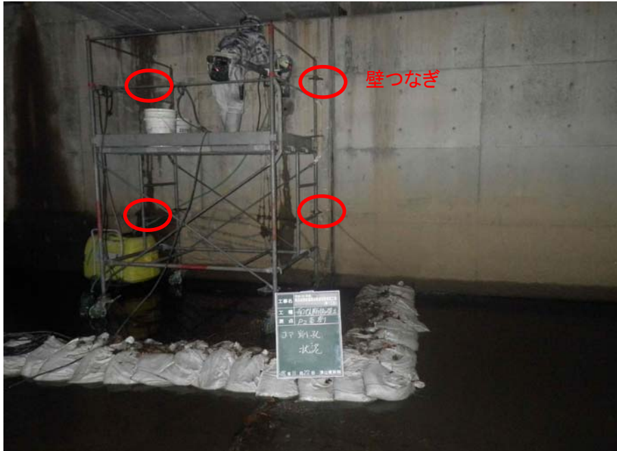
施工状況写真
