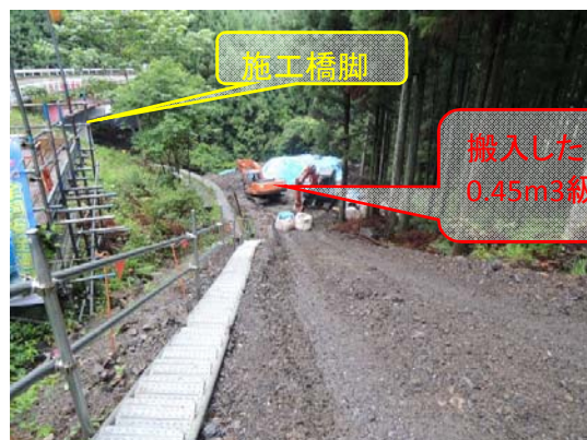
仮設道・作業員仮設通路設置完
