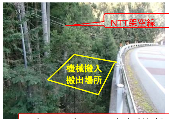
写真-2 上空にNTTの架空線等確認
