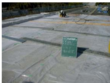
(写真4) 湿潤養生
