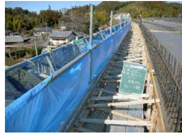
(写真2) 飛散・風養生
