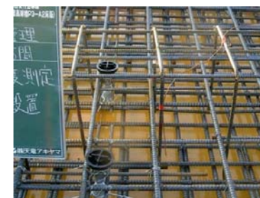
(写真7) 熱電対取付け
