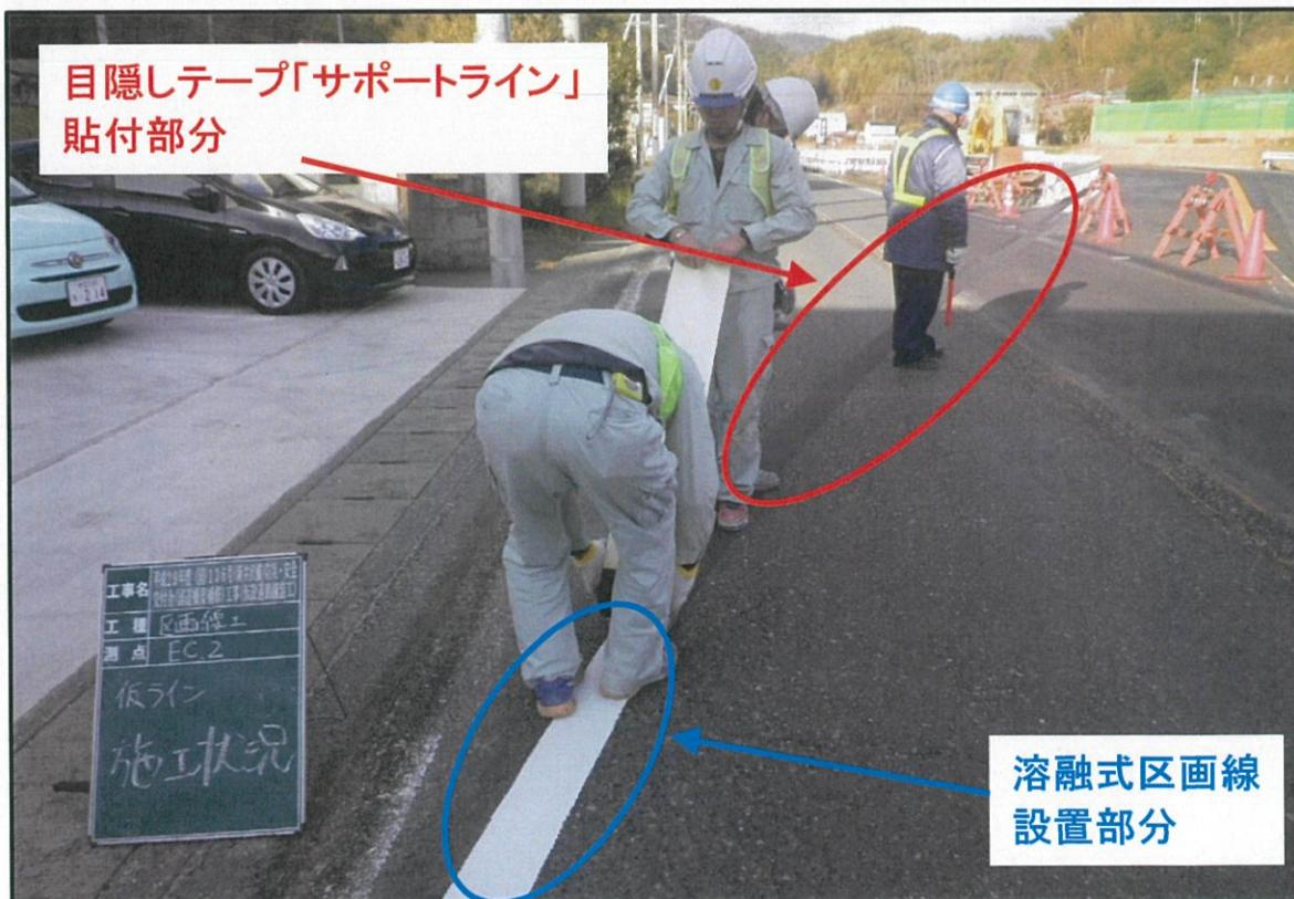
③「抹消+仮ライン」「設置+目隠しテープ」完了=交通形態(直進)の仮復旧完了
