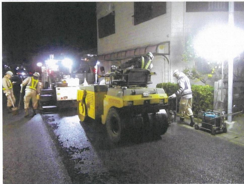
通行止め規制起終点に大型のバルーンライトを1基ずつ設置し規制箇所をアピールすることで一般車両の施工区域内への飛び込み事故を防止すると共に、交通誘導警備員の存在を目立たせ交通誘導警備員の安全確保を行いました。
