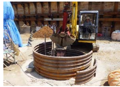
テレスコピック式バックホウによる排土作業
