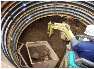
小型バックホウによる排土作業
