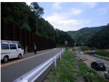
国道414号通行止め状況
