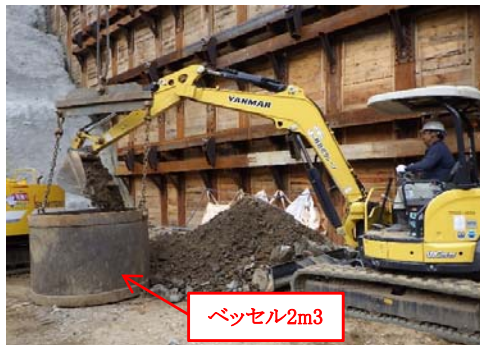
仮置土積込状況
