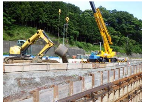
仮置土荷上げ状況
