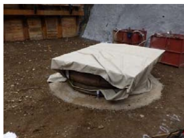
深礎坑口養生状況
