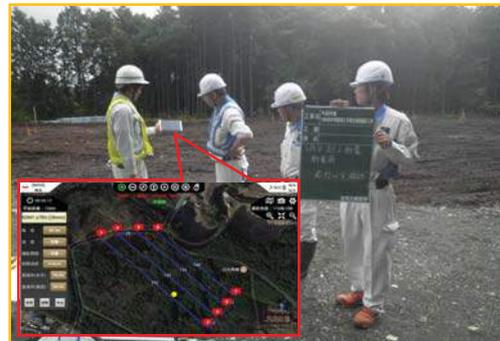
○計測点群データ、起工測量計測データの作成
