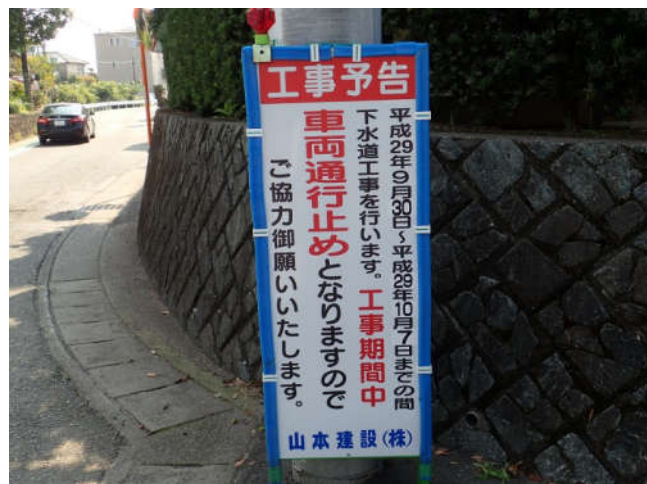
写真-4 工事予告看板設置
