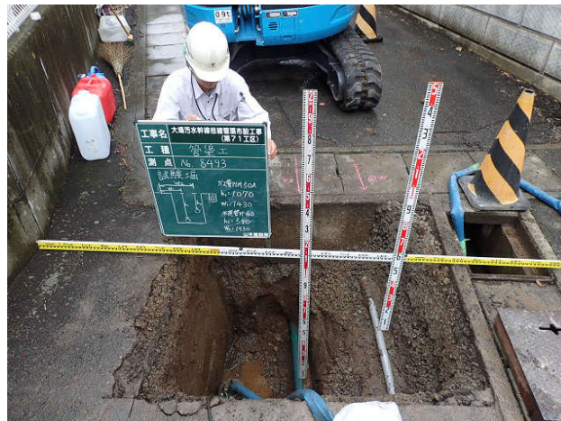
写真-1 試験掘状況
