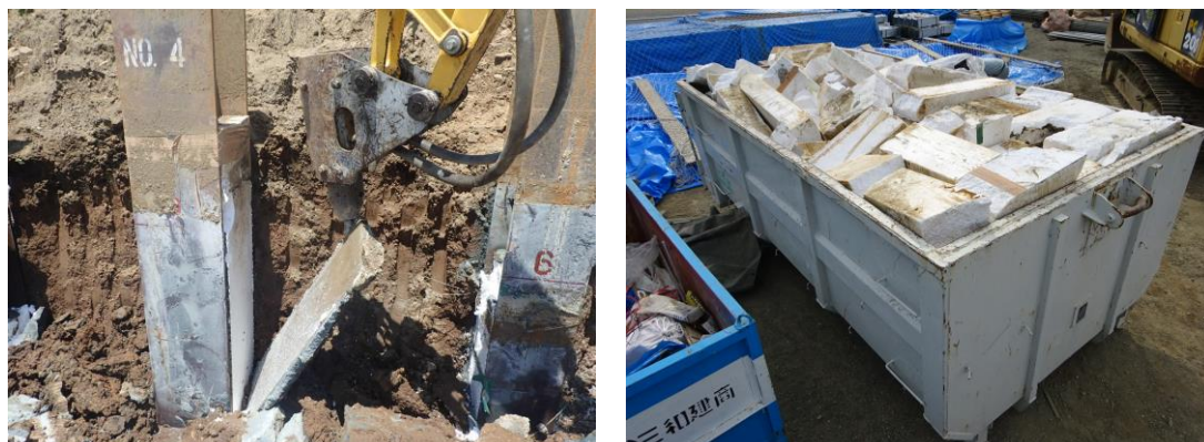
図 5 巻立てコンクリート及び発泡ポリスチレン撤去状況
