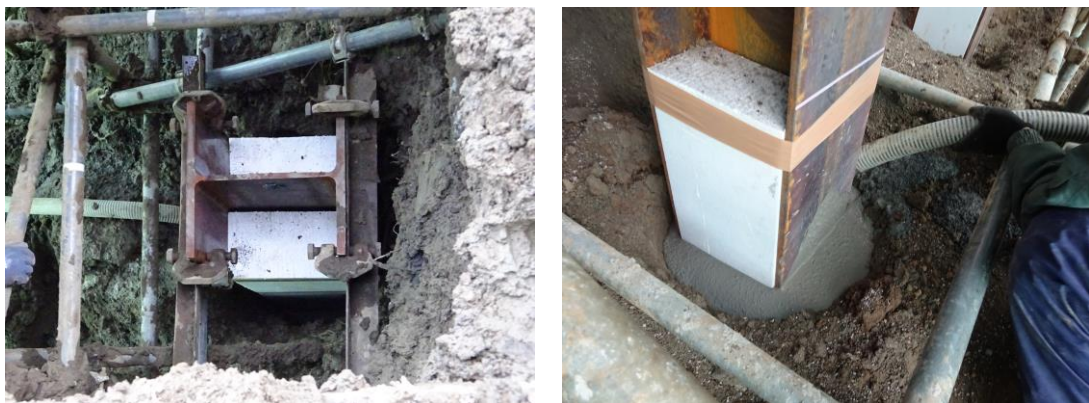
図 4 親杭巻立てコンクリート打設状況
