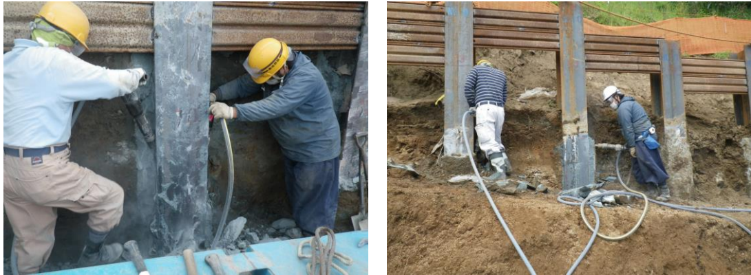
図 1 従来工法による巻立てコンクリート取壊し作業状況
