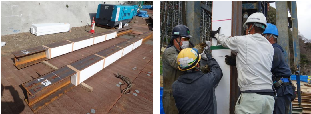
図 3 発泡ポリスチレン固定状況
