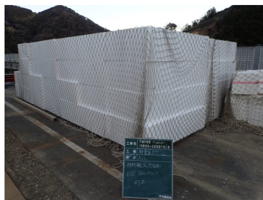
写真-10、写真-11 材料飛散養生
