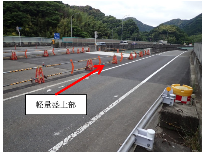
完 成（名古屋側から東京側望む）
