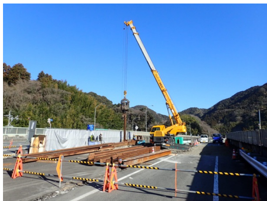
写真-3 鋼矢板打設状況
