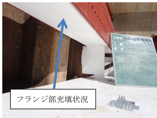
写真-6、写真-7、写真-8、写真-9 EPS 設置状況
