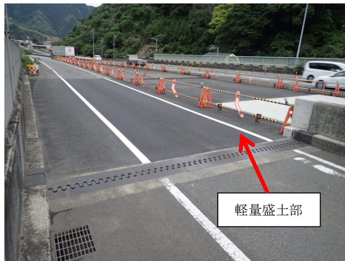
完 成（東京側から名古屋側望む）
