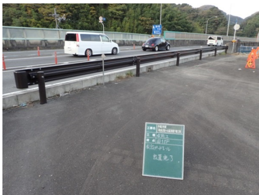
写真-2 仮設ガードレール
