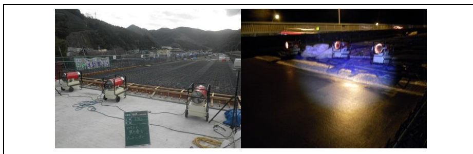
写真.2 ジェットヒーターによる保温
