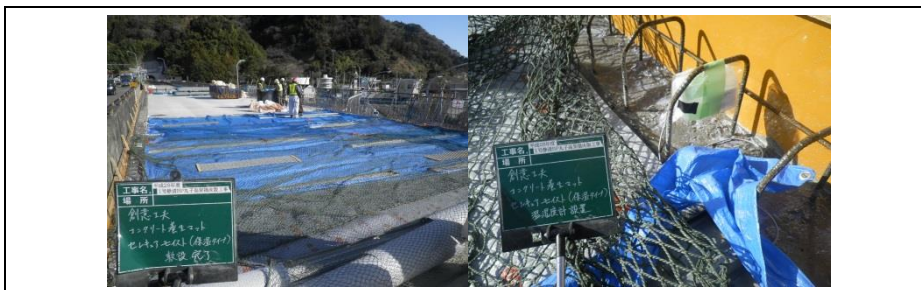
写真.3 保温力の高い養生マットの設置
