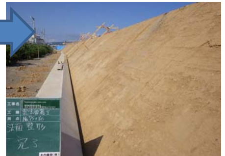
法面整形完成
