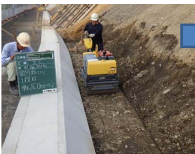
地山掘削状況
