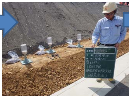
現場密度試験(砂置換法)
