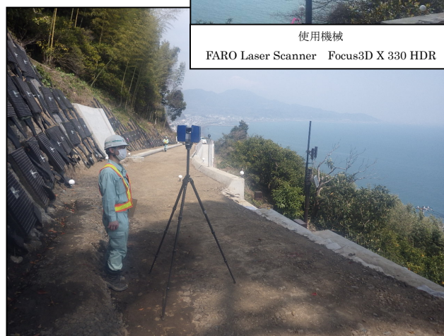
写真-3 LS 測量による出来形計測
