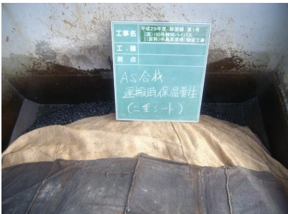
幌シート（二重）による保温養生
