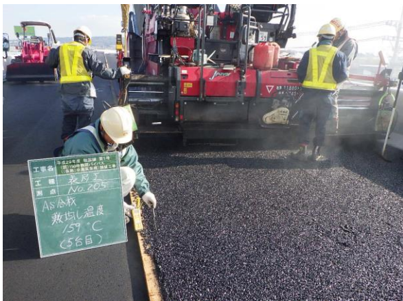
敷均し時合材温度測定
