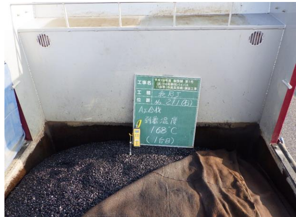
合材到着温度測定
