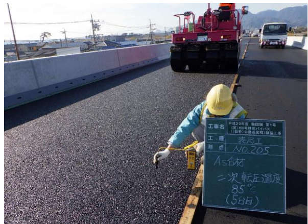
2次転圧時合材温度測定
