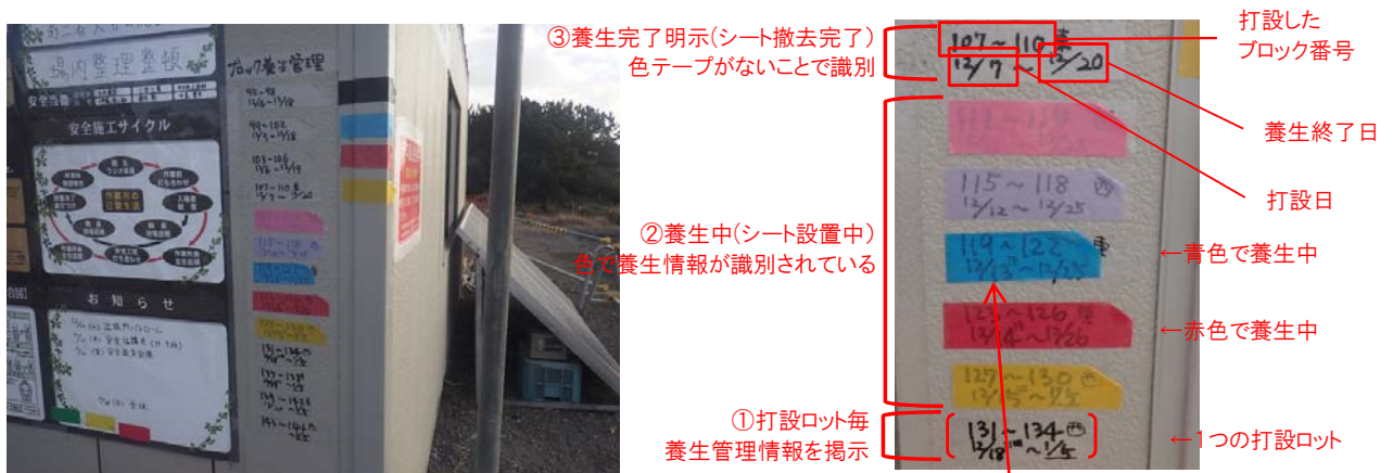
写真-4 養生管理情報明示状況
