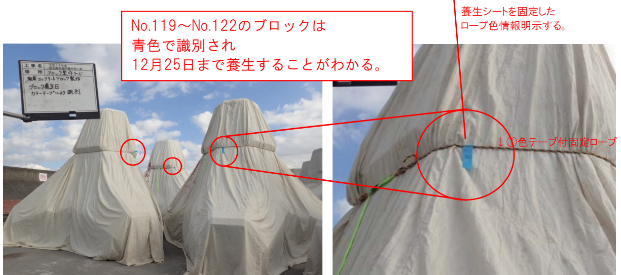
写真-5 養生シート識別（色テープ貼付）状況
