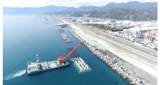
写真-1 大型消波ブロック据付状況
