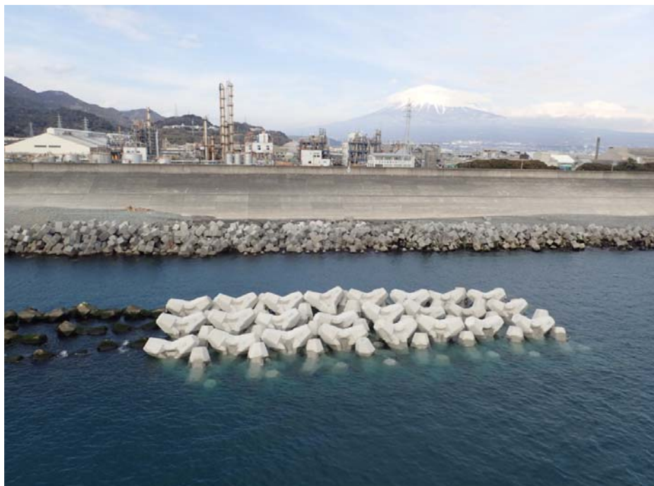
写真-6 離岸堤(延長) 完成状況
