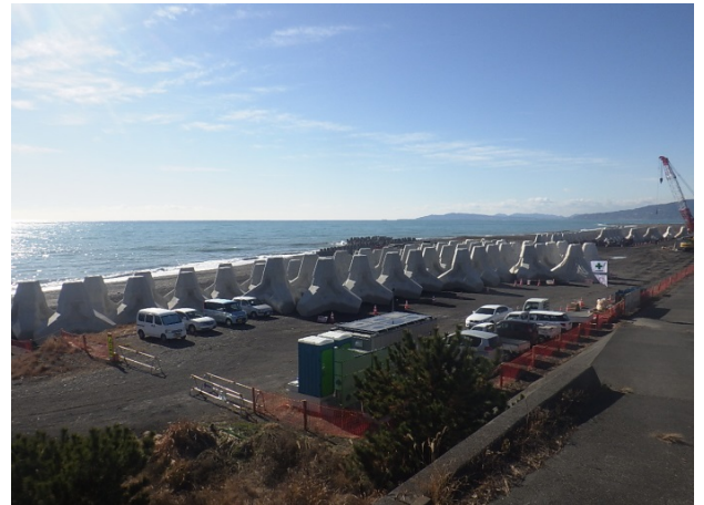
写真-3 ブロック仮置き状況
