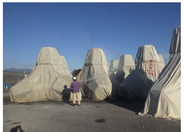
写真-2 大型消波ブロック養生状況
