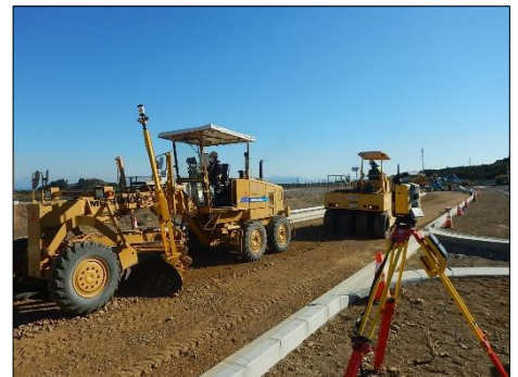
写真1: 路床施工状況
