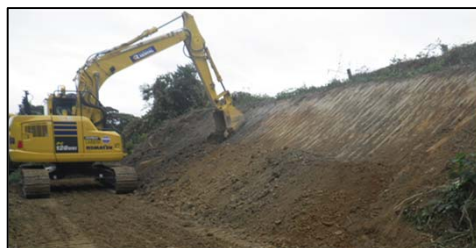
マシンコントロール機械による施工状況
