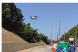
UAVによる出来形測量
