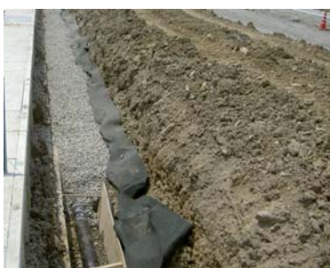
地下排水工の設置
