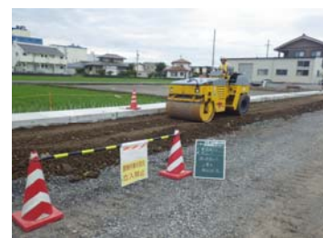
歩道転圧状況
