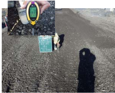
転圧前湿潤状態確認 (最適含水比内:良好)
