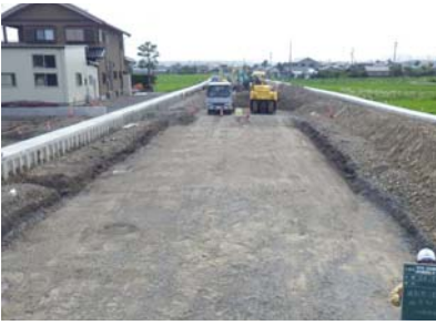
撤去完了(地盤確認:良好)
