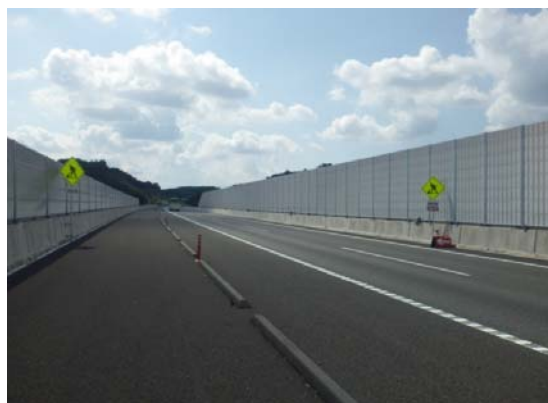
看板・矢印板増設
