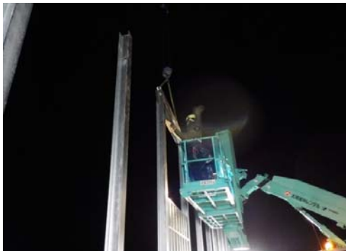
夜間支柱及び吸音板設置状況
