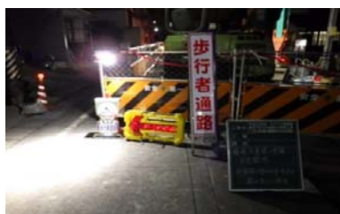
工事個所の照明
