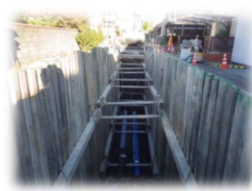
管路土留・管敷設状況
