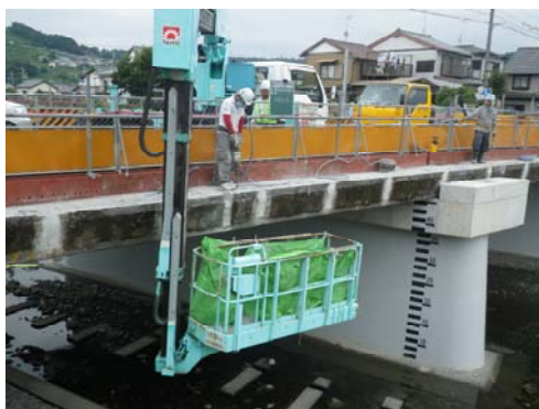
地覆取壊し状況
