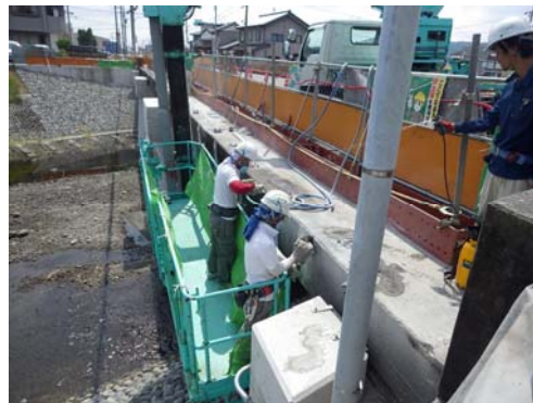
排水管部取壊し状況
