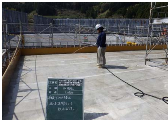
コンクリート散水状況
