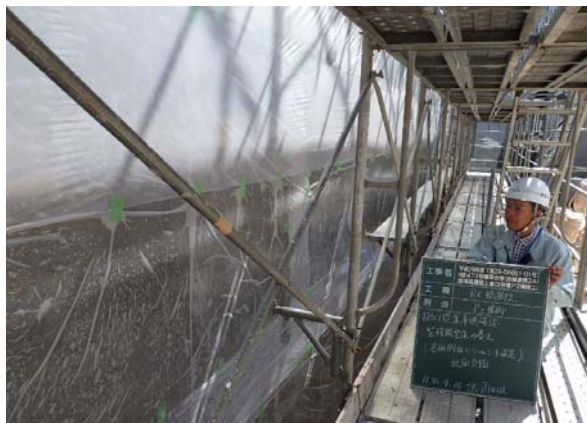
コンクリート側面養生状況
