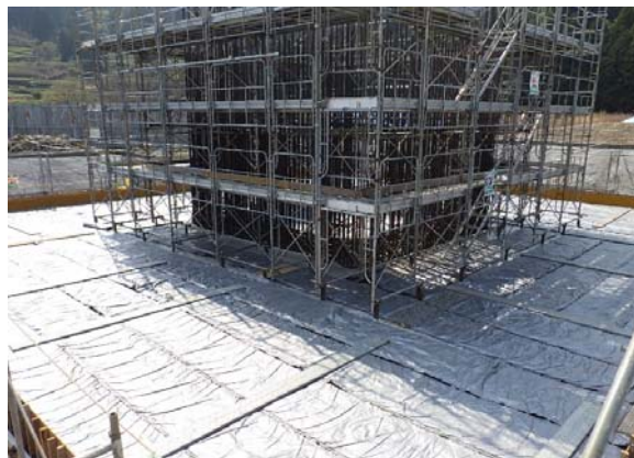
Qマット設置状況
