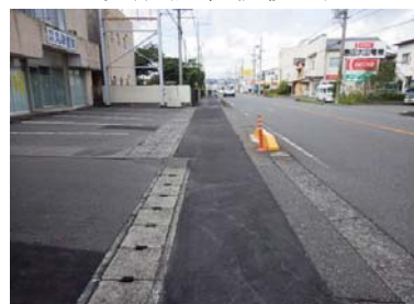
取付管工(VU150設置)
