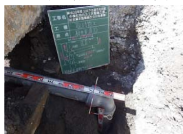
取付管工(VU150設置)
