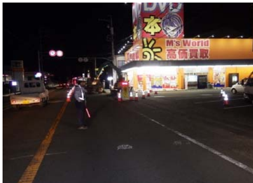
出入口部交通誘導員配置状況
