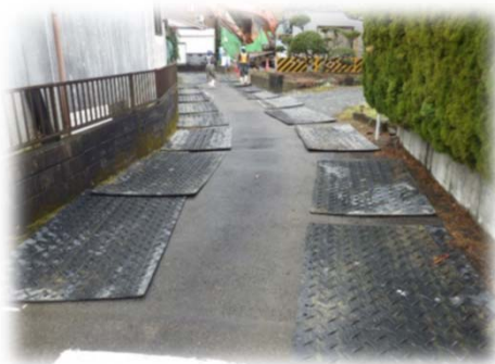
硬質プラスチック板（養生）
