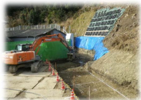
施工状況（防塵フェンス）
