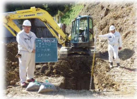
試験施工（試料採取）
