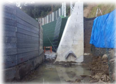
単管柵設置（民地側）
