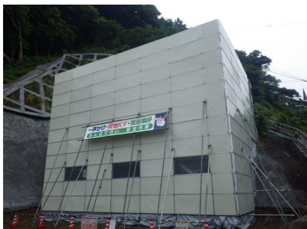
写真-3 坑口部防音パネル建屋（前面）
