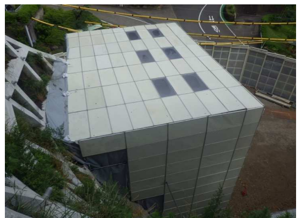
写真-4 坑口部防音パネル建屋（上面）
