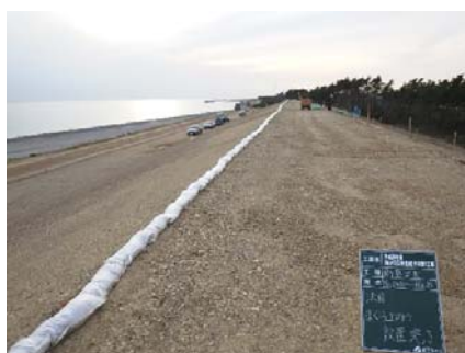
写真(6)：まくら土のう設置(終点～)
