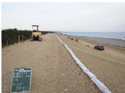
写真(5)：まくら土のう設置(起点～)
