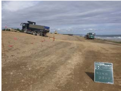
写真(1)： 坂路設置状況(海側)
