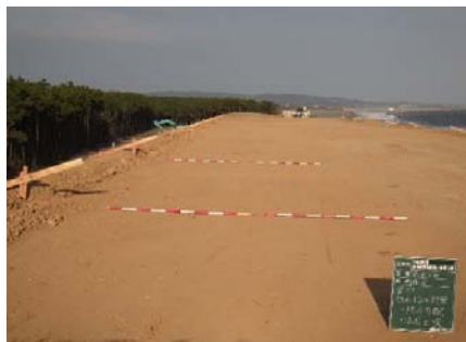
写真(3)： 山側から海側へ排水勾配
