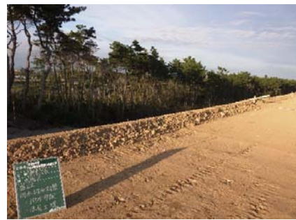
写真(4)： 法肩 土堤設置状況
