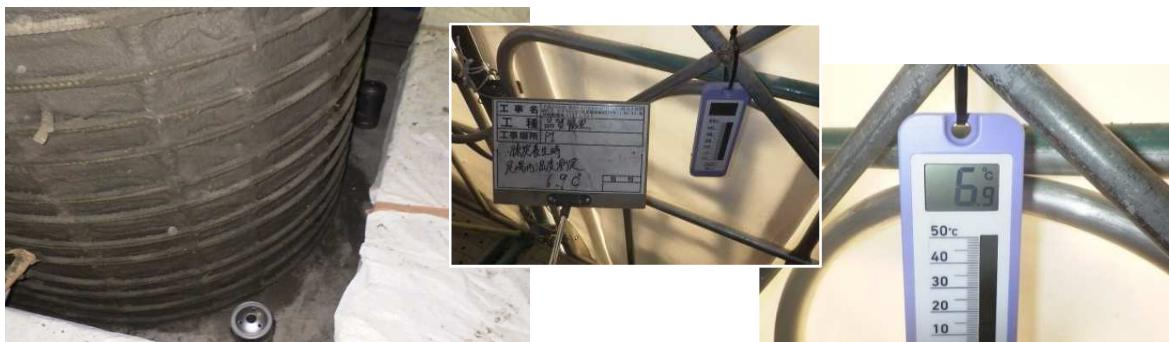
②枠組足場上面からの風による「急激な温度変化」を防止するために、シートで完全に覆った。
