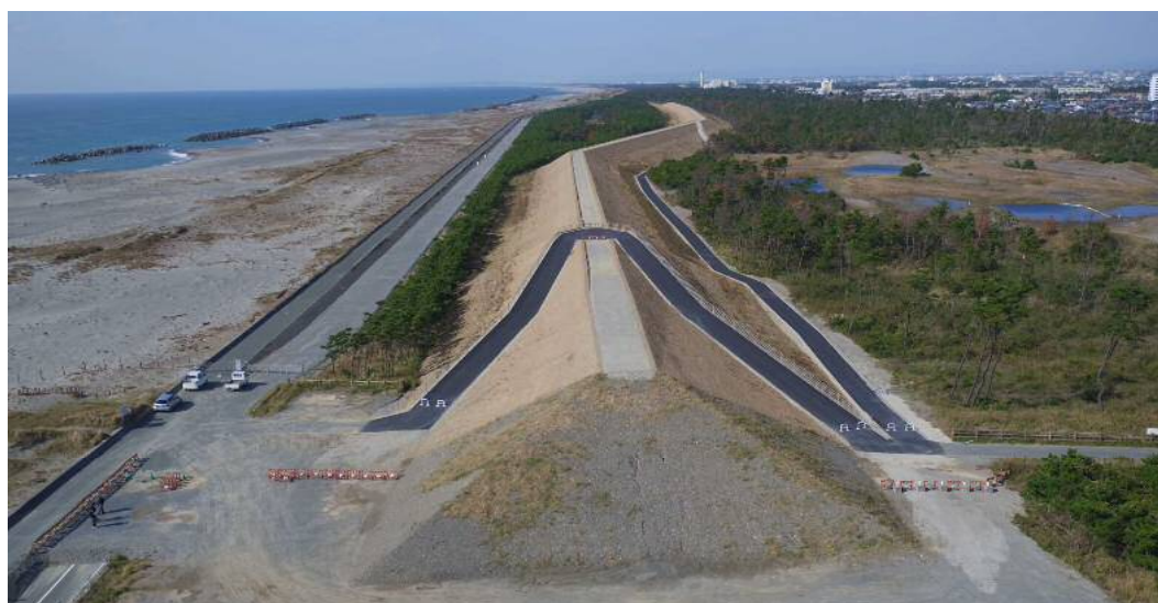
写真-2 完成した防潮堤(東から)
