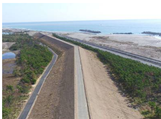
写真-3 完成(中央から東)
