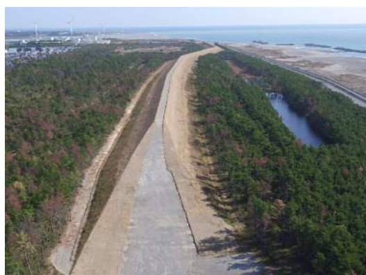
写真-4 完成(西から)
