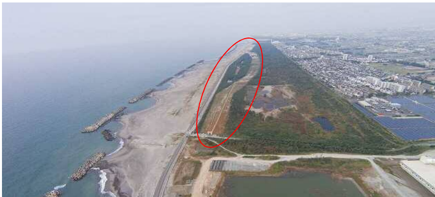
写真-1 着手前の状況(伐採完了)
