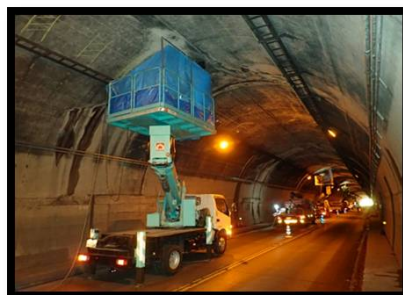
トンネル坑内作業状況
