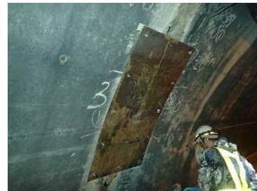
崩落崩壊箇所:対策後
