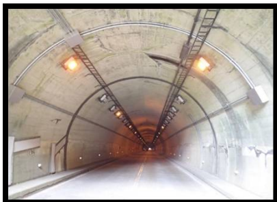
トンネル起点部からの写真
