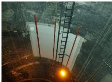
炭素繊維シート及びアングル補強
