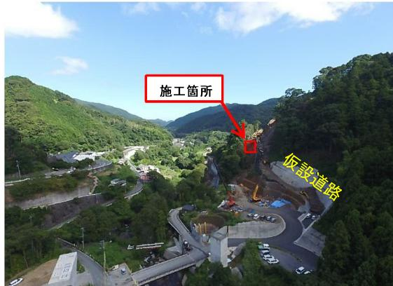
橋台施工箇所は山裾の傾斜地で、掘削後、山側に土留めを行ってから橋台の施工へと入る計画だった。現場着手の段階で、上部では本線切土及び仮設道路の工事が、また下部では橋脚3基及び工事用道路の工事が別途工事により先行して行われていた。
