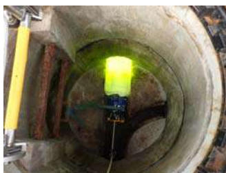
参考写真【施工状況】
