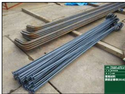
鉄筋定着体全体
