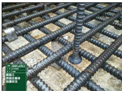
鉄筋定着体施工状況
