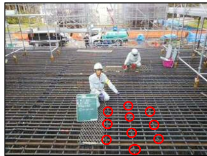
鉄筋定着体取付状況(千鳥全面)
