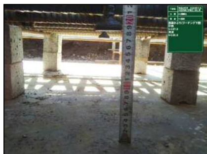
鉄筋定着体かぶり確認
