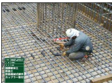
フーチング部施工状況
