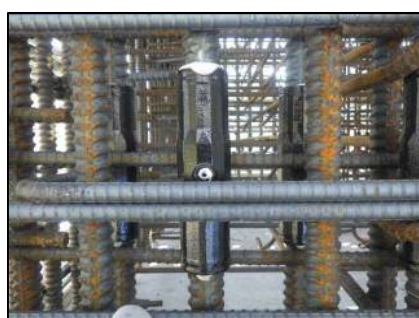
柱部施工完了
