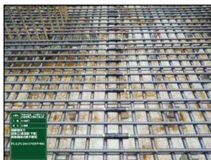
フーチング部施工完了
