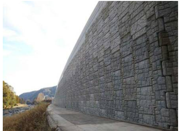
完成【西平地区】
