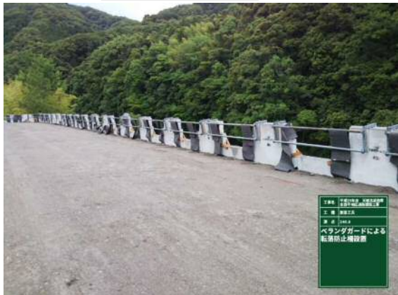
転落防止柵設置
