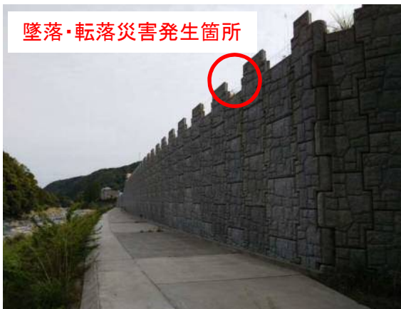
補強土壁前面から望む
