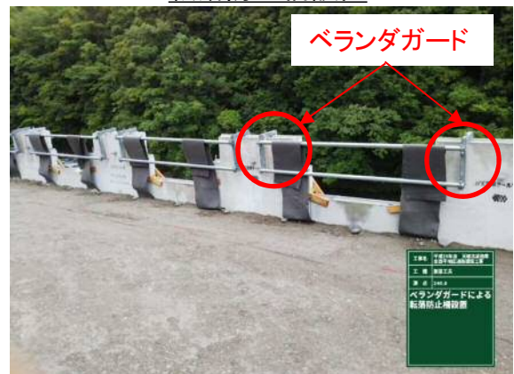
転落防止柵設置
