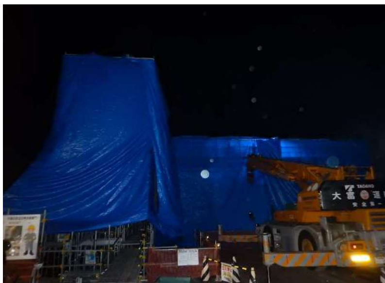
寒中養生全景
