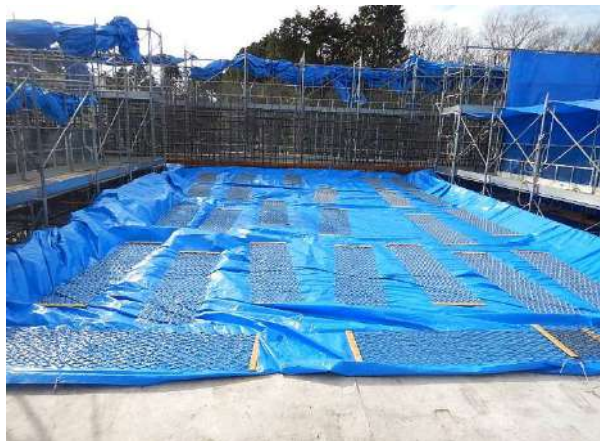
ブルーシート養生状況
