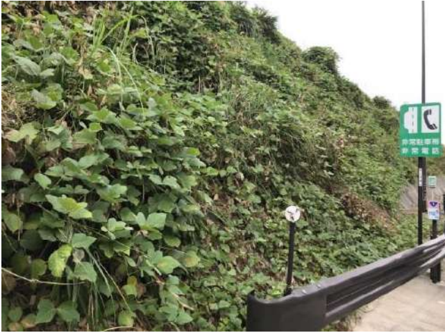
着工前 法面除草
