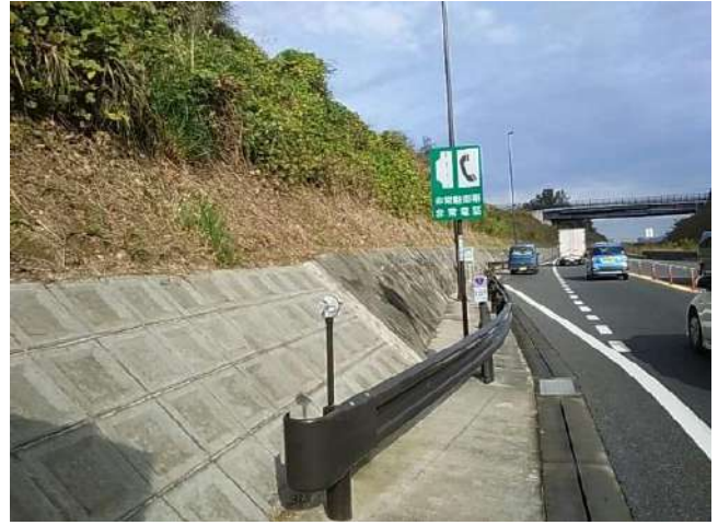
完了 法面除草
