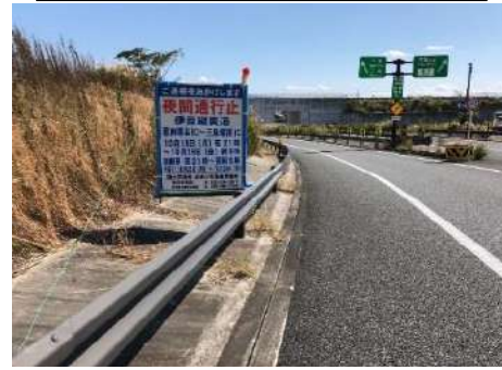
新東名高速道路料金所付近
