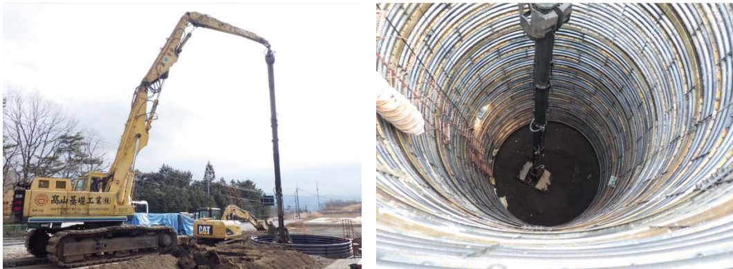
クラムシェル掘削状況
