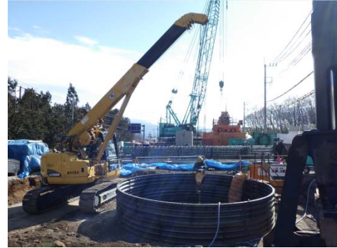
バックホウ型移動式クレーンの使用
