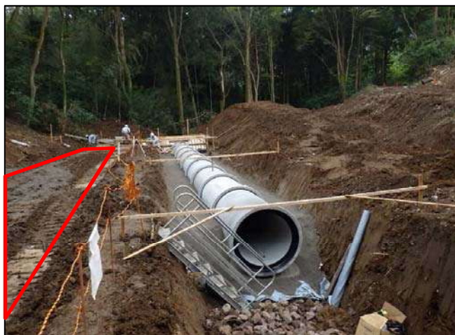
鉄板敷設状況
