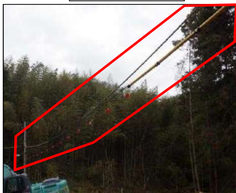
防護管設置状況
