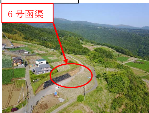
1 段階目施工前
