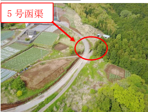
2 段階目施工前
