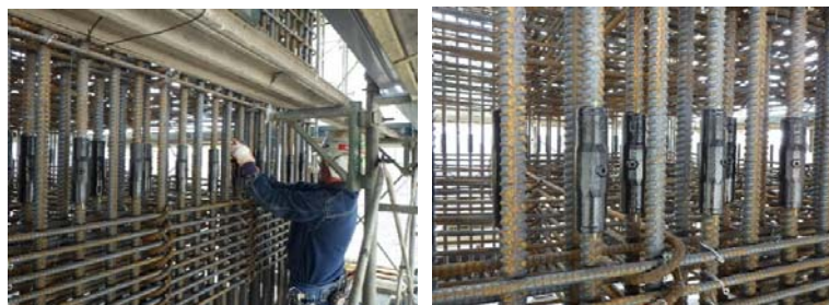
機械式鉄筋継手設置状況
