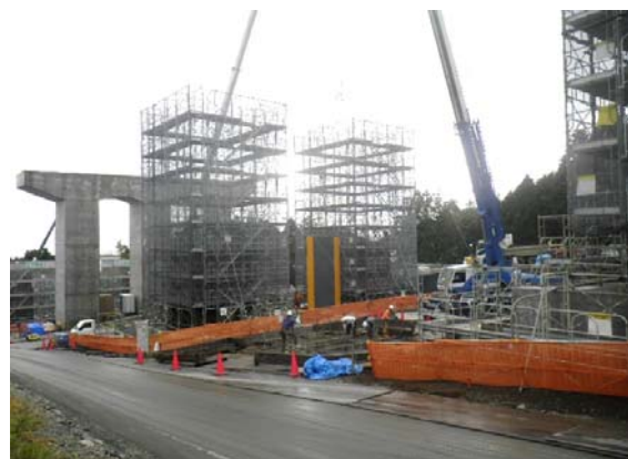
システム型枠建込状況
