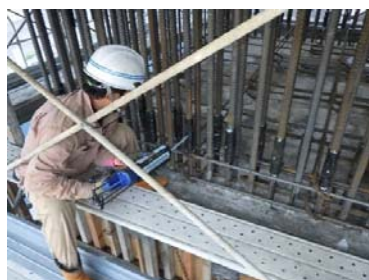
グラウト注入状況
