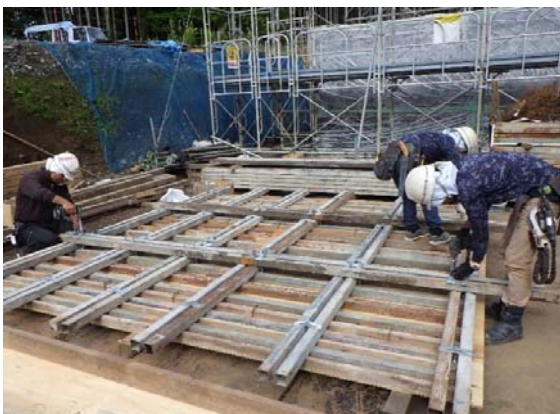
システム型枠地組状況
