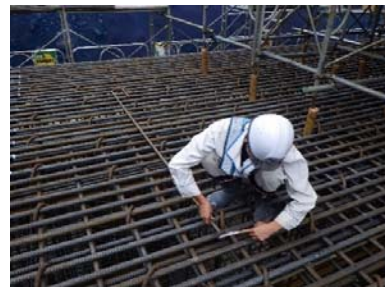
機械式鉄筋定着体
