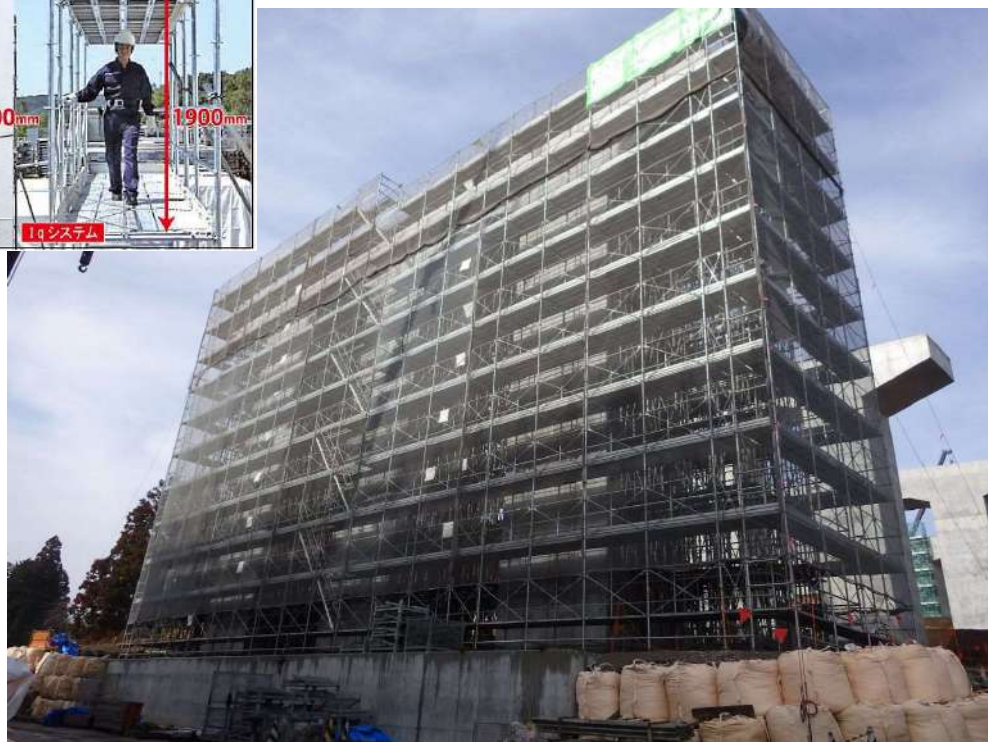
次世代足場組立状況
