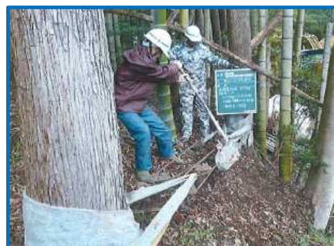
立木アンカー引張強度試験
