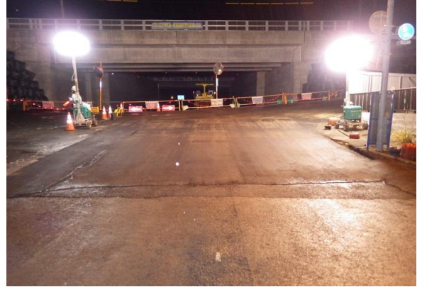
H. 段差部仮舗装
