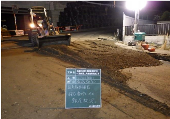
G. 段差部仮盛土工
