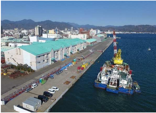
図2-3. 被覆工 施工状況写真
