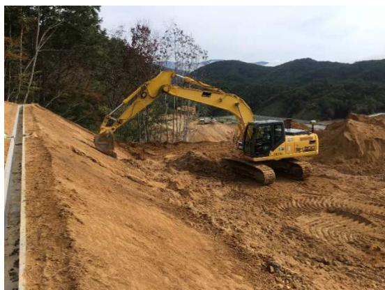
法面整形状況
