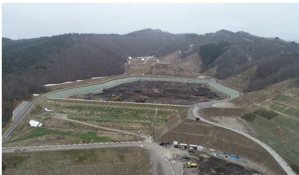
着手前現場写真
