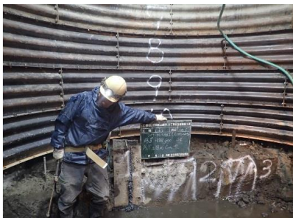
立坑内で確認した連続地中壁
