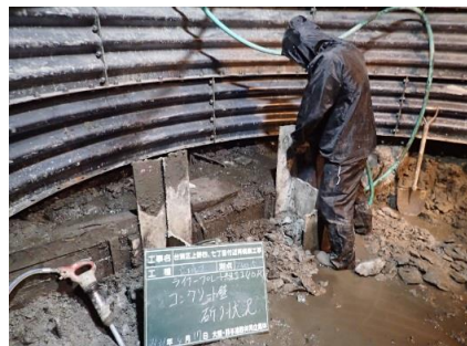
連続地中壁の研り状況
