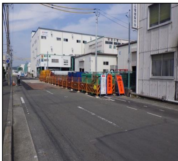
写真-7 道路解放状況
