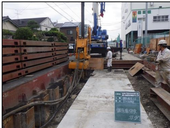
写真-5 作業状況
