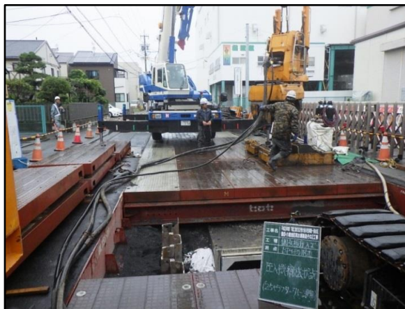
写真-6 機械設備撤去状況
