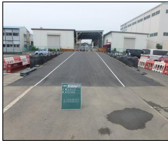
写真-4 仮設通路設置状況
