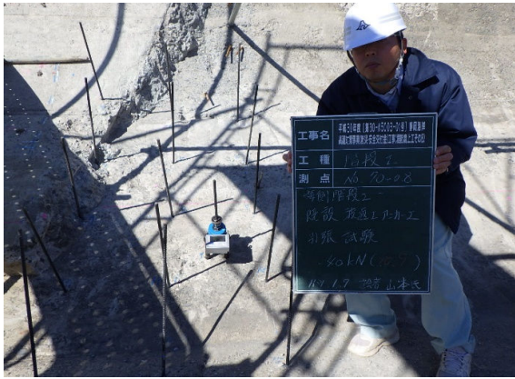
追加アンカー完了立会状況
