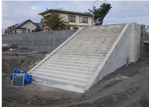
海側階段工完了
