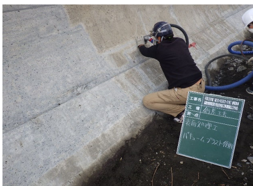
バキュームブラスト施工状況
